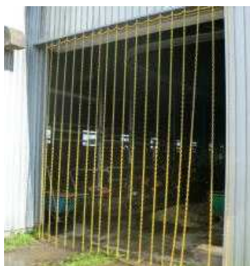
チェーンネットでカラス侵入防止
