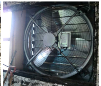
換気を良く 牛舎内の湿気やホコリを追い出し、乾燥させる事で、雑菌の増殖をシャットアウト
