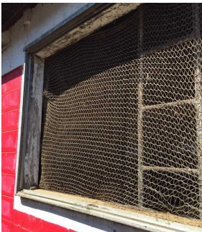
野生動物の侵入防止 牛舎の開口部にネット設置などで侵入を防ごう
