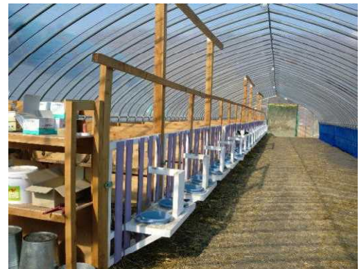
写真1 新設したほ育施設
