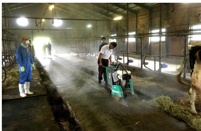
コンクリートカッターによる通路の溝切り
