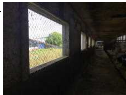
窓を取り外しネットを利用して網戸を設置しました。
