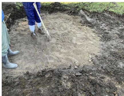
②火山灰の敷設
