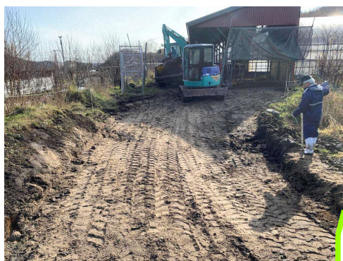
④再度火山灰を敷設し、踏圧
