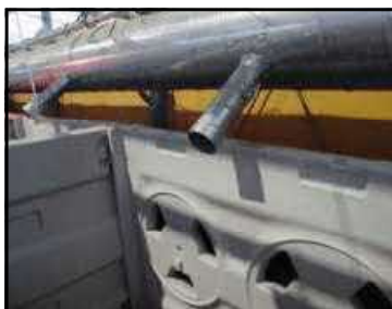
送風口が細くなっている ので風圧も十分 夏は、送風のみで利用できます
