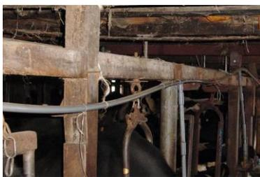
写真1 口径が細く、曲がった配管
