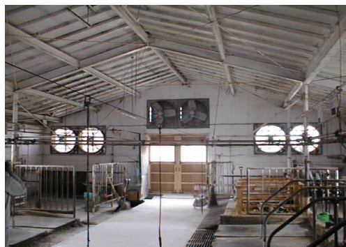
写真1 冬はインバーター、換気扇1台で
