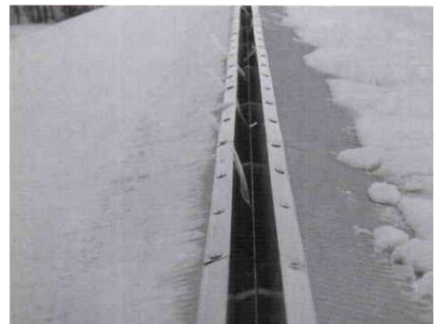
写真2 オープンリッジからの排気
