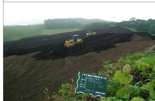
3 表土戻し 16t級湿地ブルドーザ
