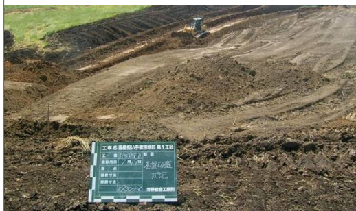
2 基盤切盛 16t級湿地ブルドーザ
