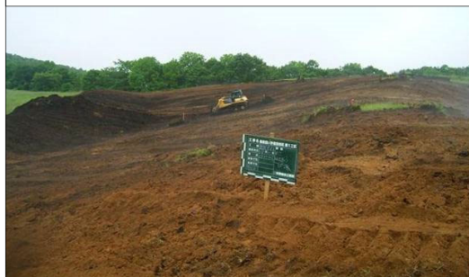
1 表土剥ぎ 16t級湿地ブルドーザ
