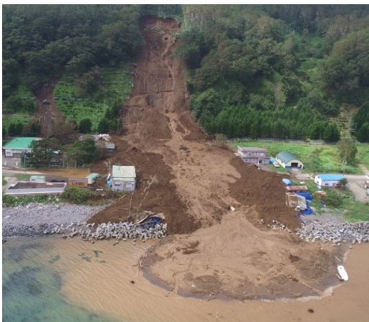
【平成28年8月 知床公園羅臼線の土砂崩れ(羅臼町)】
