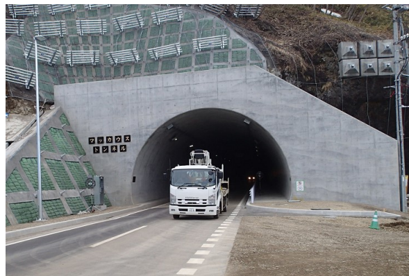
【マッカウストンネル(羅臼町)】 トンネル延長498.5mの内、150mに防水型構造(ウォータータイト)を採用し、平成26年3月に供用開始
