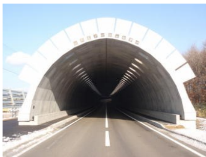
【中標津標茶線スノーシェルター(別海町)】
