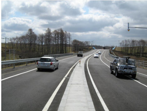
【根室中標津線(別海町)】
