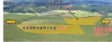
図2 通過土砂量と堆積土砂量 ・令和6年8月出水では土砂調整地上流地点の通過土砂量約238m 3 のうち、約81m 3 が調整地内に堆積。
