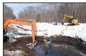
<沈砂池土砂上げ>
