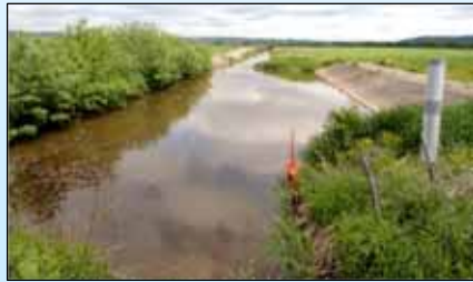
<鶴居第1地区 2号沈砂池>
