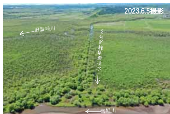
写真2 雪裡川と2号幹線明渠排水
