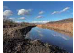
<沈砂池（土砂上げ後）>
