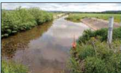
< 鶴居第1地区 2号沈砂池 >
