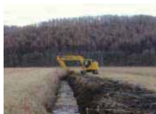
<附帯水路土砂上げ>
