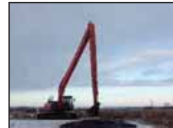
<排水路土砂上げ>
