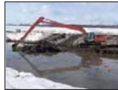
<沈砂池土砂上げ>
