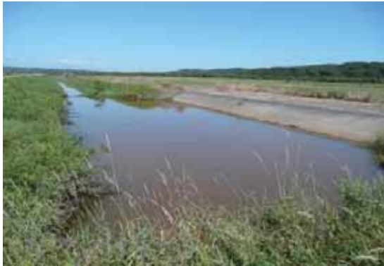
<鶴居第1地区 2号排水路沈砂池>
