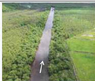
写真1 雪裡川直線河道
