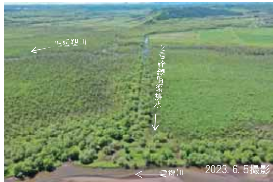
写真2 雪裡川と2号幹線明渠排水
