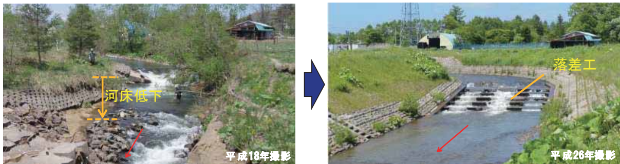
落差工の対策前後の状況
