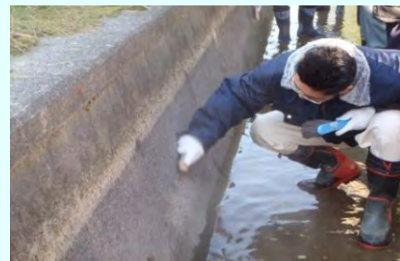
コンクリート劣化状況の調査（用水路の機能評価）
