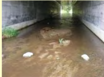
施工後1年経過した状況
