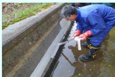
用水路のコンクリート表面の補修（施設の長寿命化対策）
