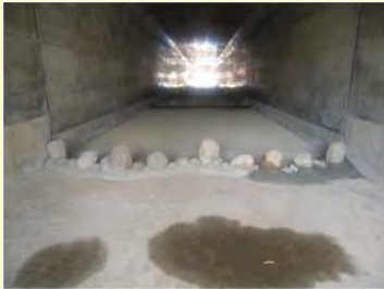
函渠工内部の石張帯工
