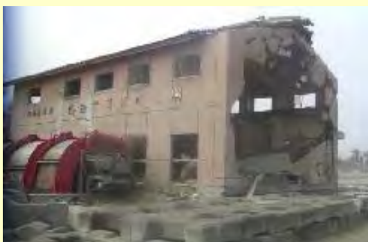
津波による排水機場の被災状況
