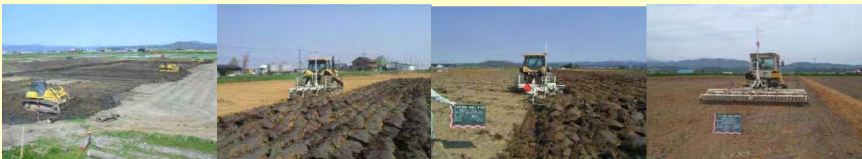
① 切土部の作土と心土をブラウで反転 ② 切土部心土をブルで盛土部に移動 ③ 切土部心土と盛土部作土をブラウで反転 ④ レーザーレベラーで均平作業
