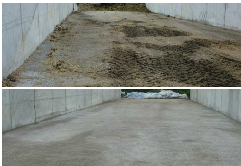
【写真2、3】高压洗浄機での清掃例(上:洗浄前、下:洗浄後)サイレージの下面が黒くなくなくなり、ロスが減ったとの事。
