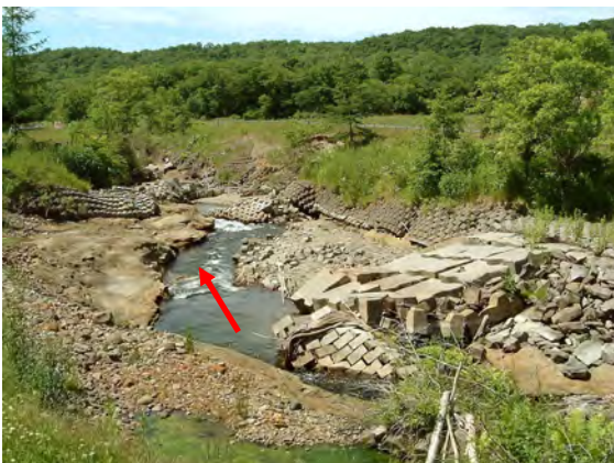
KP16.0 付近の河床低下区間の状況(1)
