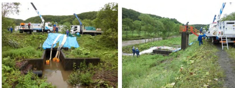
排水ポンプ車による排水状況（平成 26 年 7 月撮影）
