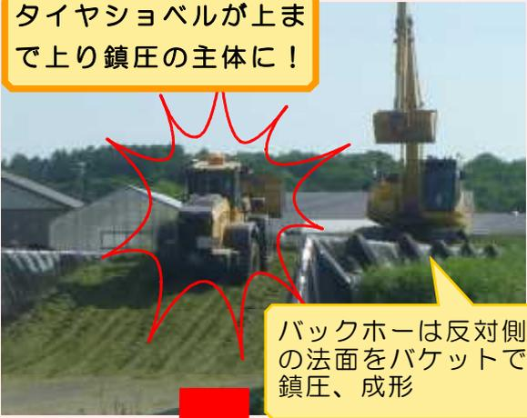
バックホーは反対側の法面をバケットで鎮圧、成形
