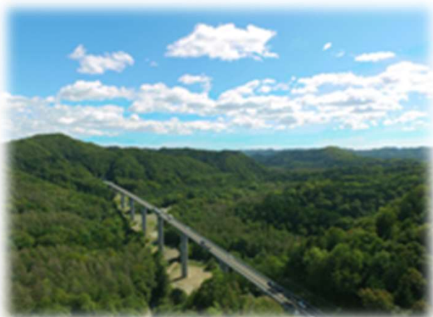
北海道横断自動車道（里音別川橋）
