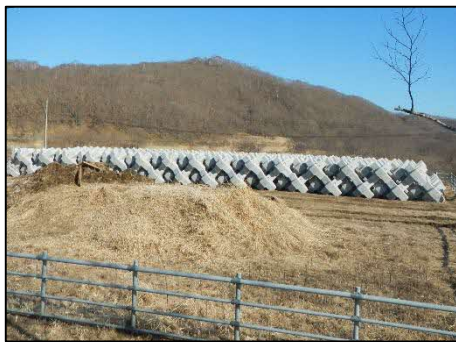
根固めブロック備蓄状況
