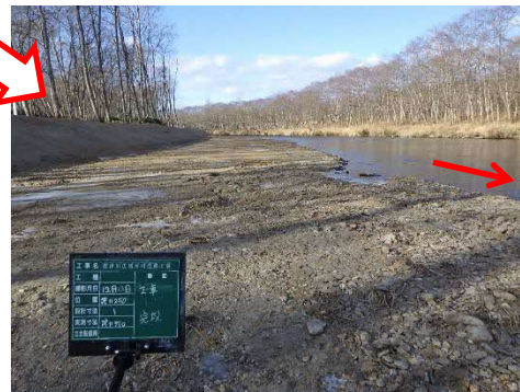
河道掘削 施工後
