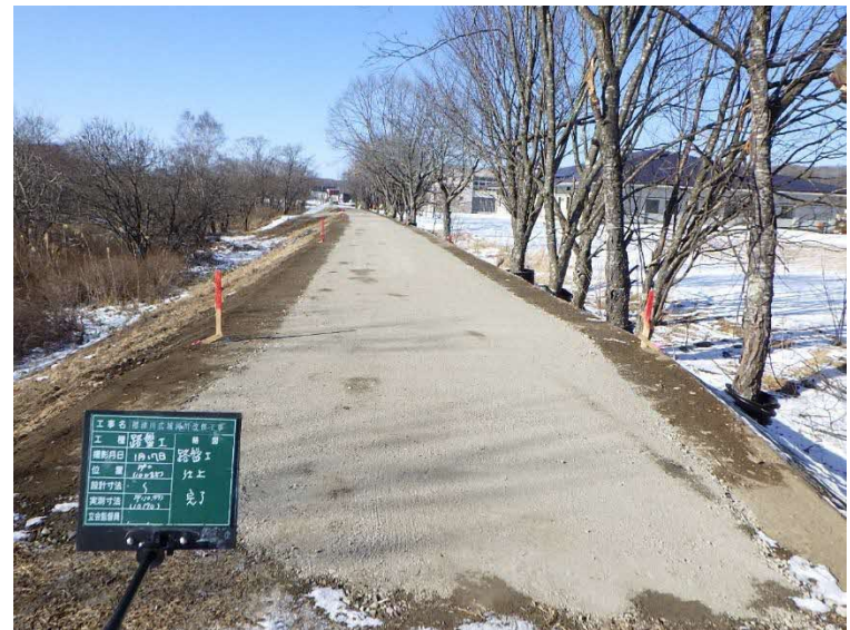
堤防天端舗装 (路盤工)
