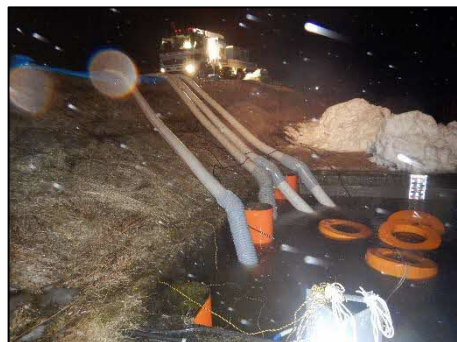
災害対策車派遣状況 (令和2年3月11日下オソベツ樋門)
