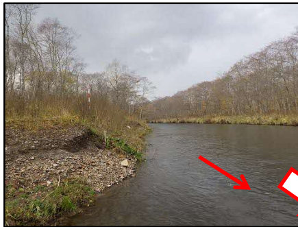
河道掘削 施工前
