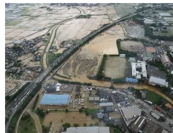
桂川における浸水被害
