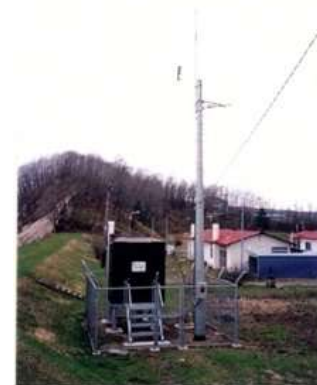
水位観測局舎
