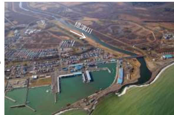
標津町市街地を流下する標津川
