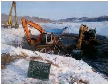
沈砂池土砂上げ状況
