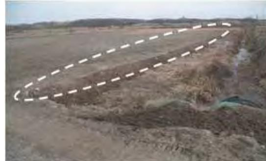
置土の工事では、圃場の周囲に圃場内の発生土を用いて土堤状に盛土を行い、土砂流出防止に努めています。
