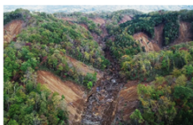
地震による被害地
