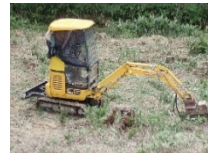
機械による下草刈り作業
