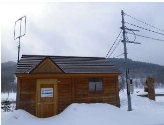
帯広建設管理部・茂足寄中継監視局
