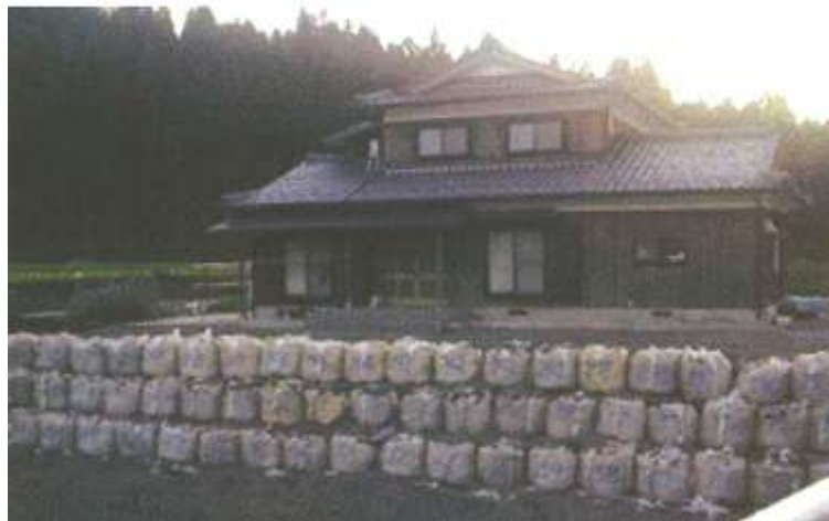
図 5.1 囲ぎよう堤の事例
