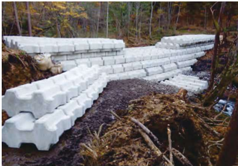
図 5.5 鹿ノ瀬川に設置したブロック堰堤
