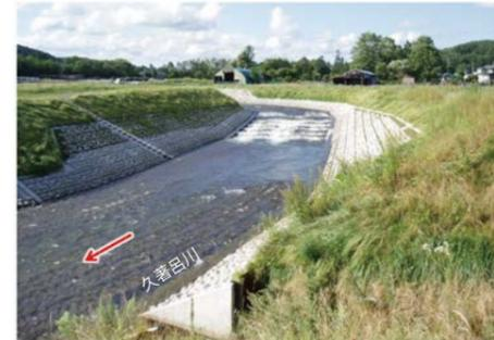
平成19年から河道拡幅、床止め工の工事に着手し、対策を実施しながらモニタリングを行っています。
