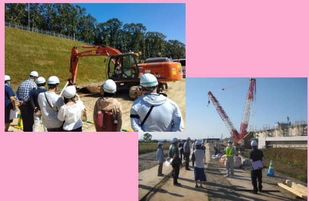
道東道開通PRインフラツアー
