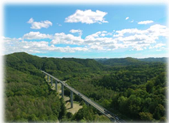
北海道横断自動車道（里音別川橋）
