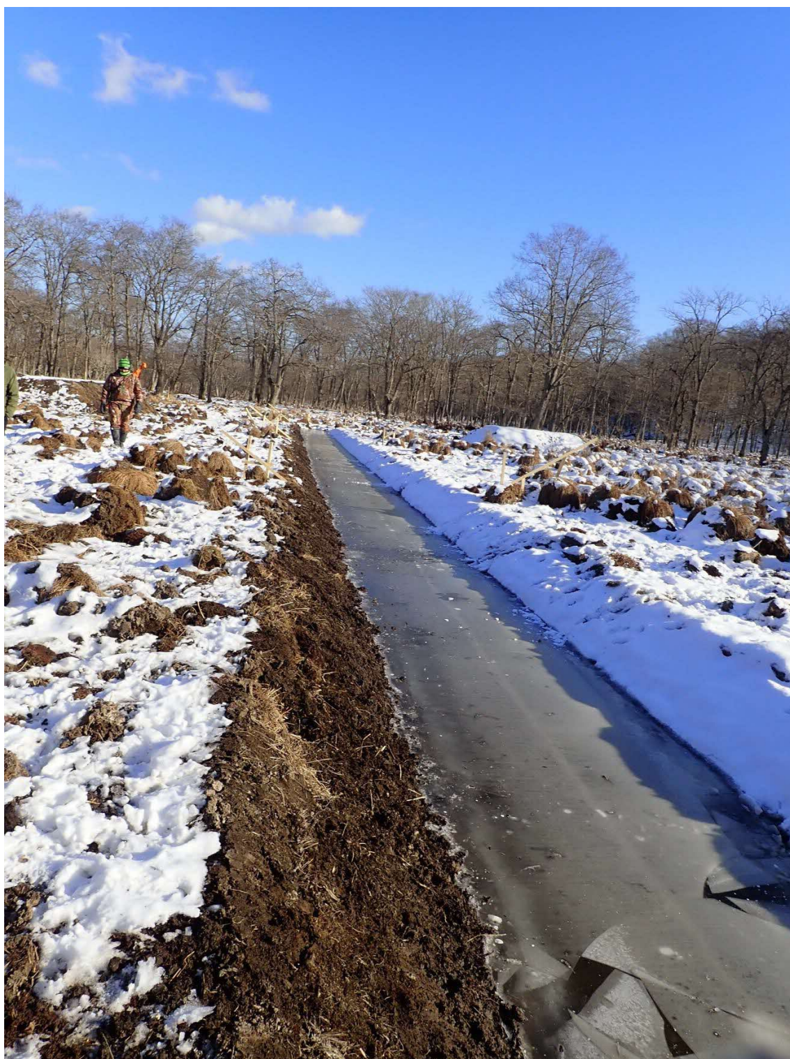
写真番号② 施工完了後の水路状況
