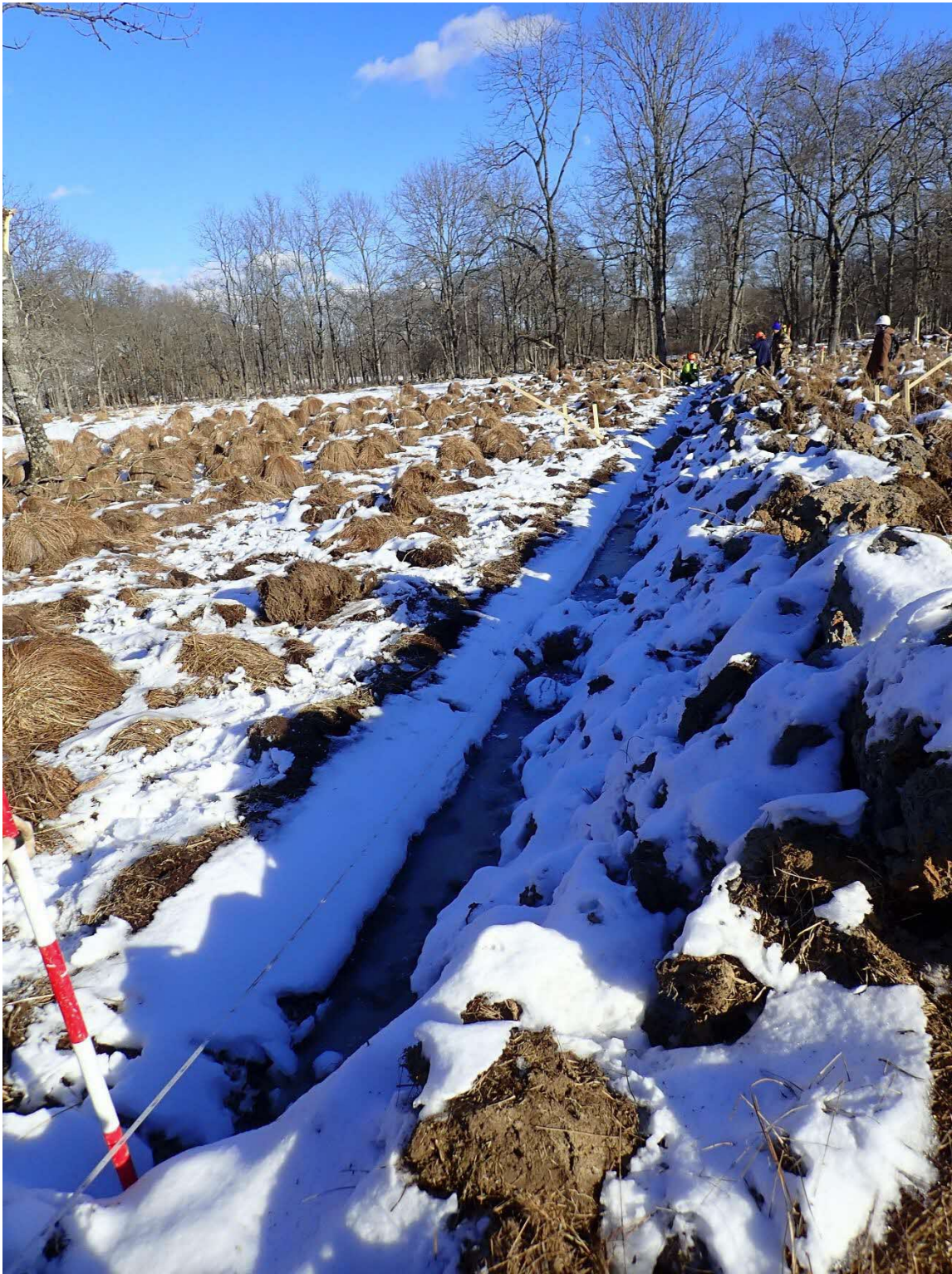
写真番号③ 施工中断した水路状況
