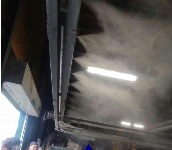
入気口側からミストが散水される
